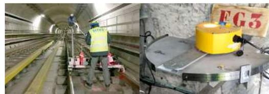
Relevé ScanTubes® d'un tunnel ferroviaire.
