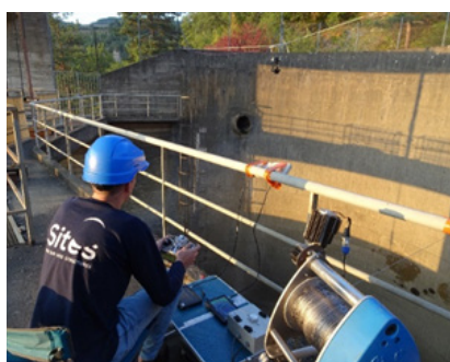
Le ScanTubes® en progression dans une cheminée d'équilibre
