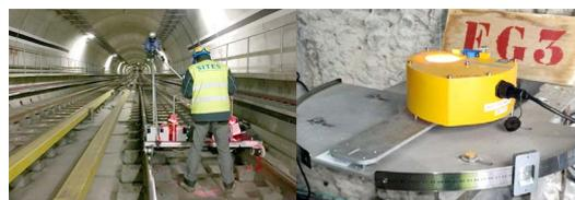
Relevé ScanTubes® d'un tunnel ferroviaire.
