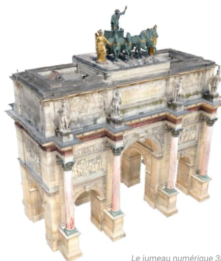
Le jumeau numérique 3D de l'Arc du Carrousel du Louvre, créé à partir de techniques photogrammétriques, pour permettre de suivre l'état de santé de l'ouvrage.
