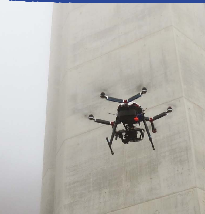
Inspection d'une pile du viaduc de Millau
